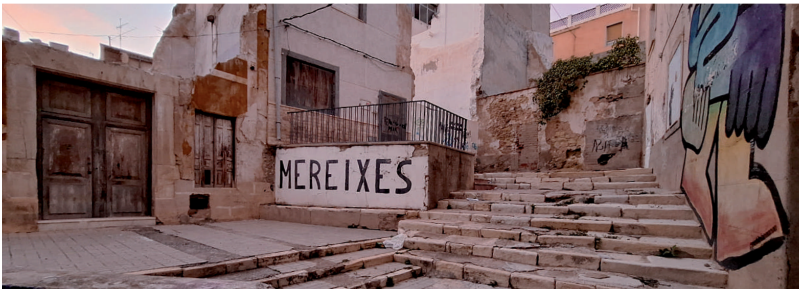
Estat actual de la zona a rehabilitar
